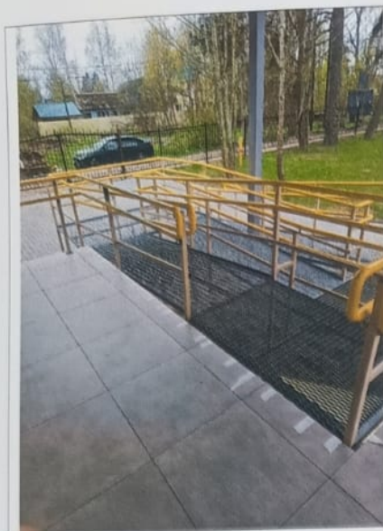
Фото № 11 – Входная площадка.
