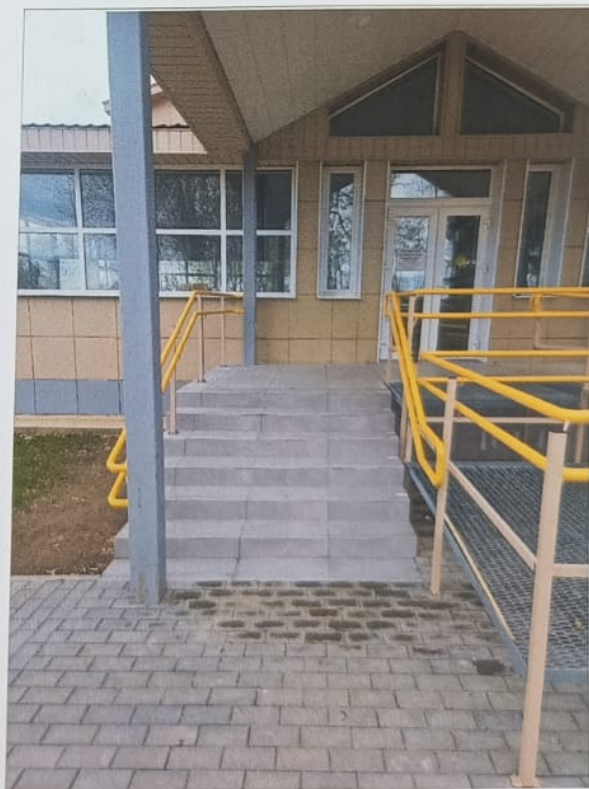
Фото № 10 – Наружная лестница. Входная площадка.
