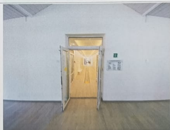
Фото № 16 – Пути движения внутри здания (двери).
