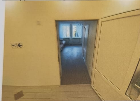
Фото №25 – Пути движения внутри здания (двери в жилые комнаты).
