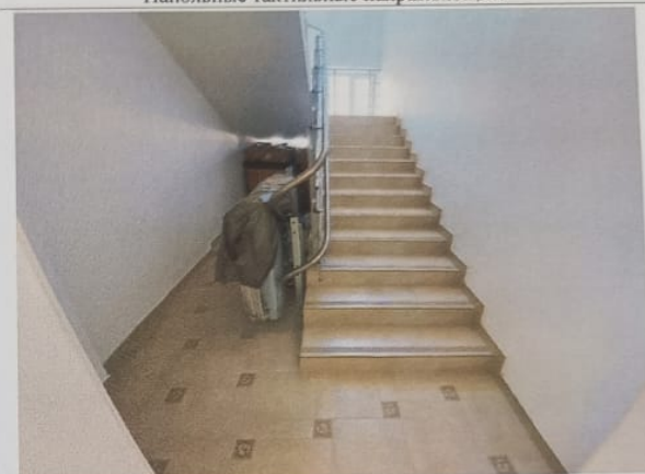
Фото № 20 – Пути движения внутри здания. (лестница). Наклонный подъёмник, доступный для МГН (К).
