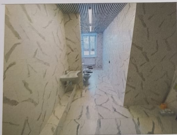
Фото №39 – Санитарно-гигиеническое помещение, общего пользования.
