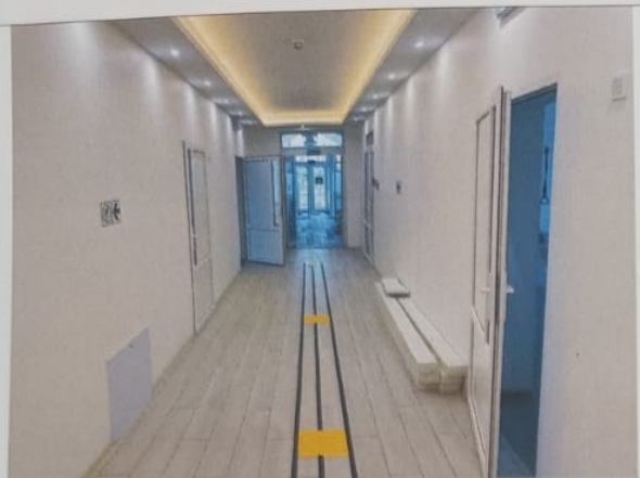
Фото № 17 – Пути движения внутри здания. Напольные тактильные направляющие.
