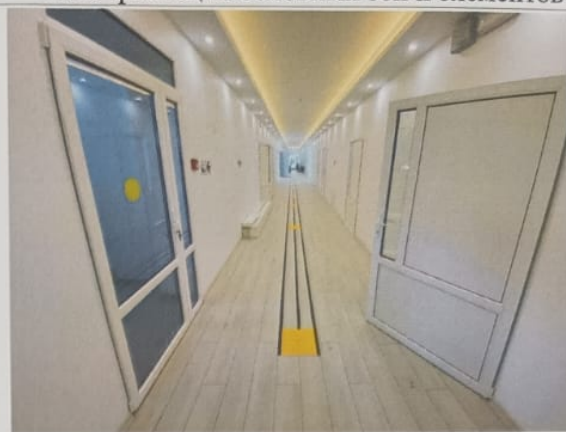
Фото № 18 – Пути движения внутри здания. Напольные тактильные направляющие.
