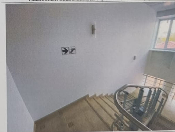
Фото № 22 – Пути движения внутри здания. (лестница). Информационный пиктограммы.
